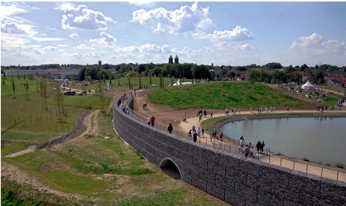
Abb. 50: Wasserfläche und begehbare Lärmschutzgabionenmauer nach Fertigstellung (2009)
