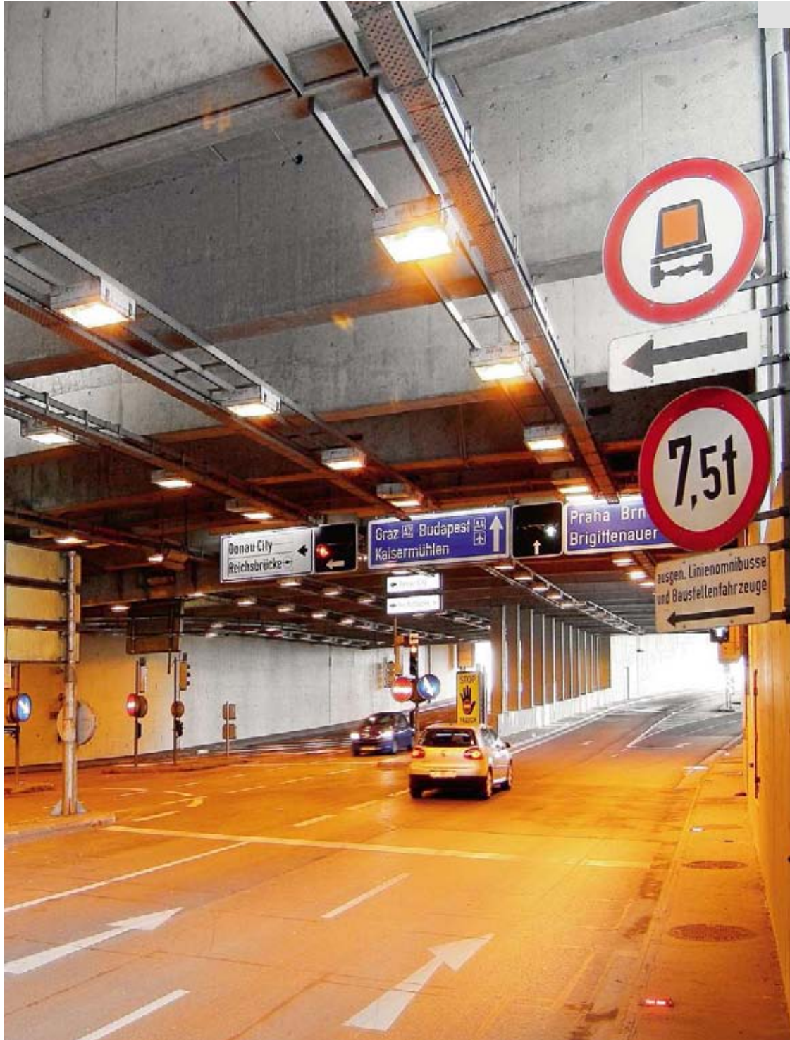
Auch die meisten Erschließungsstraßen im Quartier verlaufen unterirdisch. So bleibt der lästige Verkehrslärm im wahrsten Sinne unter dem Deckel.
