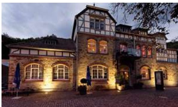
Aufwendig saniert: der historische Bahnhof.
