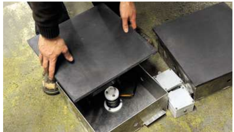
Rechts: Das Kernstück der Platten ist ein Miniaturgenerator.
