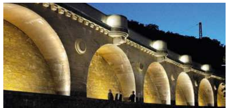
Neu in Szene gesetzt: die Bogenstützwand der Bahn.
