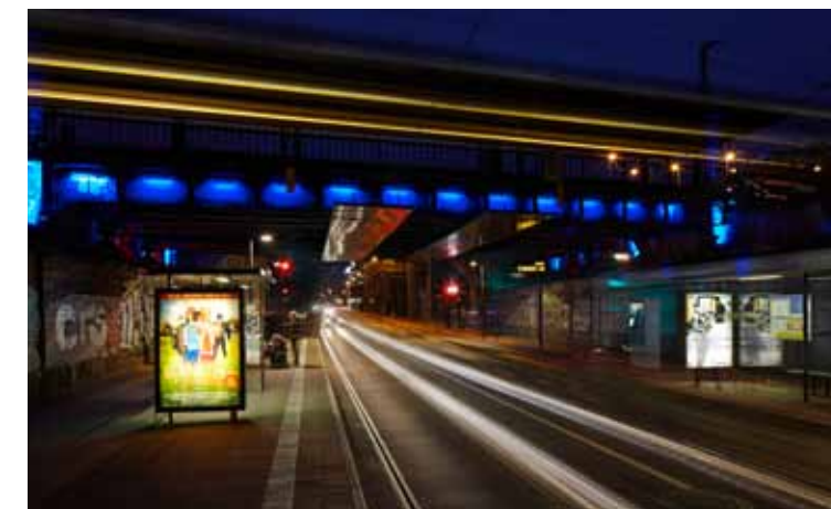
Förderprojekt der Stiftung „Lebendige Stadt“: Der vorher düstere Tunnel an der Leipziger Lützowstraße hat sich durch die künstlerische Illumination in eine helle Lichtpassage verwandelt.
