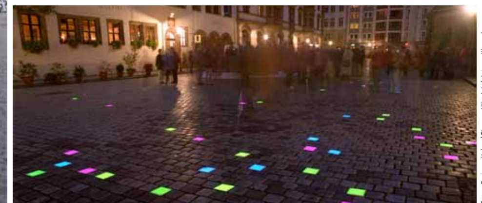
Für die Lichtinstallation wurden Pflastersteine durch farbige Lichtwürfel ersetzt.
