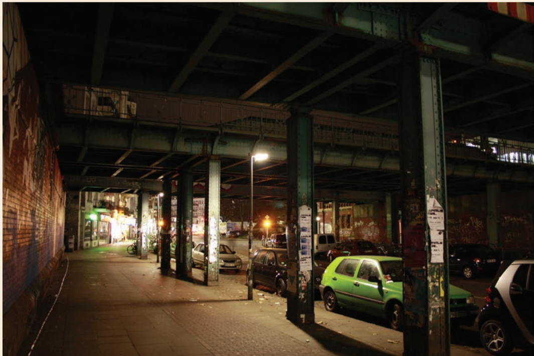
Vor der Illumination: Schwach ausgeleuchteter, dunkler Brückenraum
