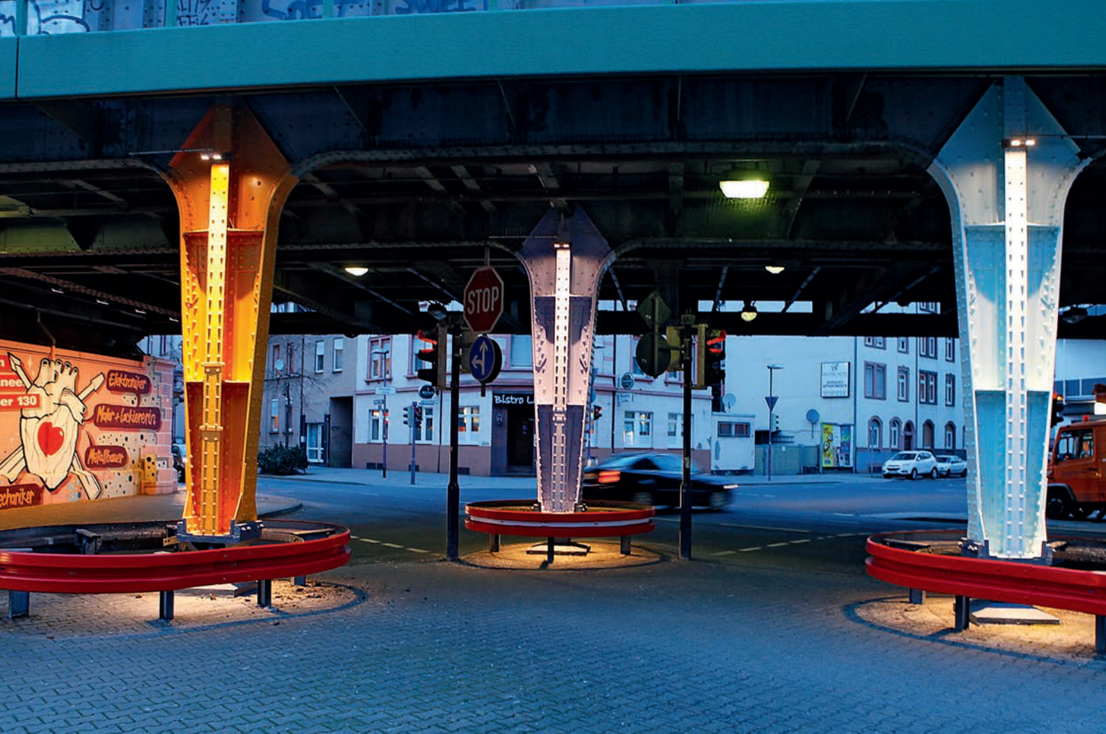
Die Bahnunterführung Bieberer Straße in Offenbach präsentiert sich mit neuer Beleuchtung und neuer Wandgestaltung. Auszubildende aus dem regionalen Handwerk haben die Wände gemeinsam mit Handwerksmeistern gestaltet. Das Motiv ist eine Idee des Limburger Graffiti-Künstlers Christian Wagner von „100 Herz Kreativkultur“.
