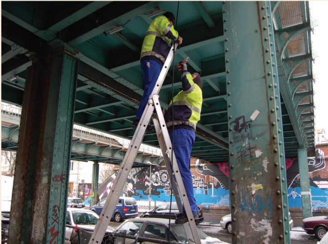
Installation des Leuchtmateriales durch die Landesinnung der Elektrohandwerke
