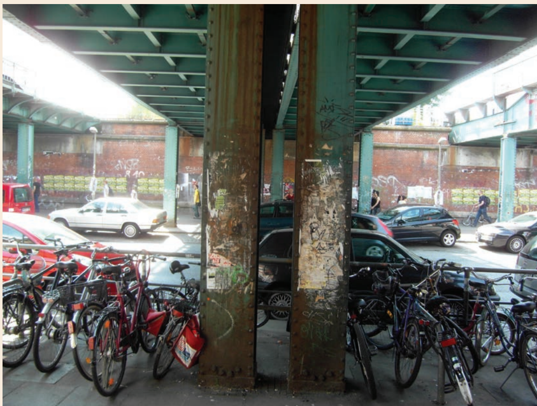
Vor der Illumination: „Wilder Ort“ unter der Sternschanzenbrücke
