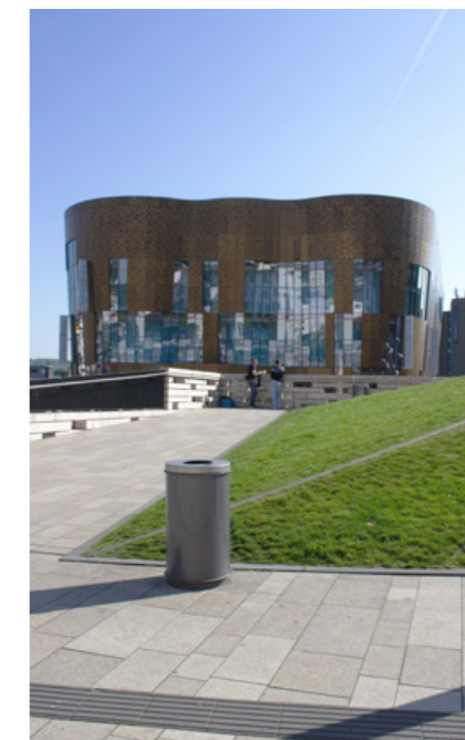
Abbildung 3 ▲ Geschäftshaus am Neuen Döppersberg
