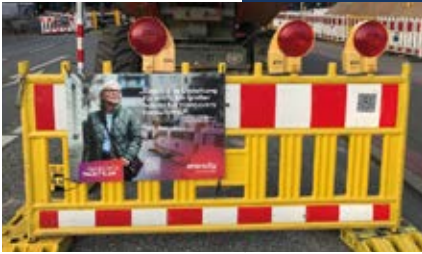
Abbildung 8: Baustelle Fernwärme Hannover (Quelle: Landeshauptstadt Hannover).
