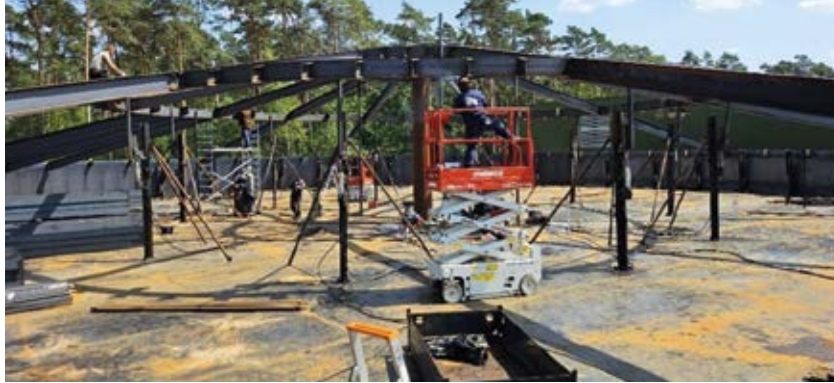
Abbildung 13: Bau eines Wärmespeichers (Quelle: Jürgen Weber).
