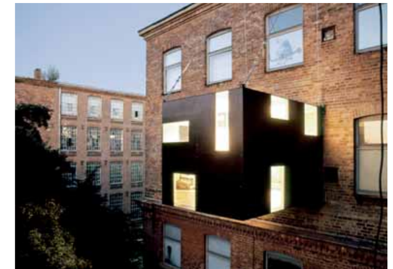
Das „Rucksack-House“ des Münchner Architekten Stefan Eberstadt wird mit Stahlseilen angehängt.
