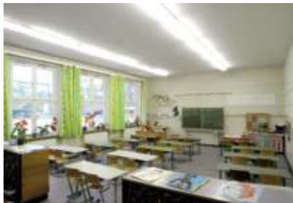
Das Klassenzimmer vor der Renovierung mit blendenden Leuchten an der Decke.
