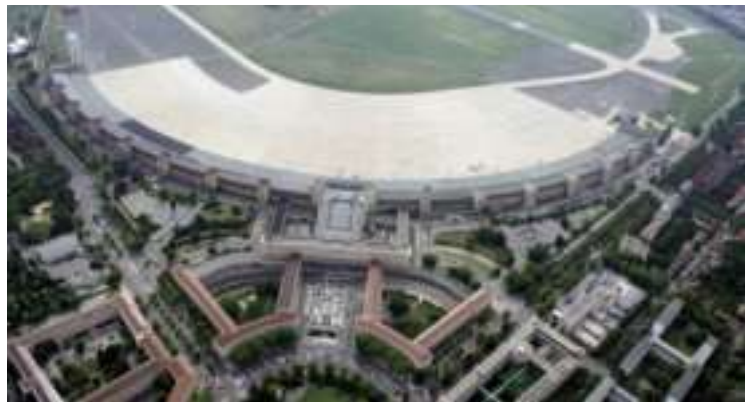
Mit einer Bruttogeschossfläche von 284.000 Quadratmetern das flächengrößte Gebäude der Welt.
