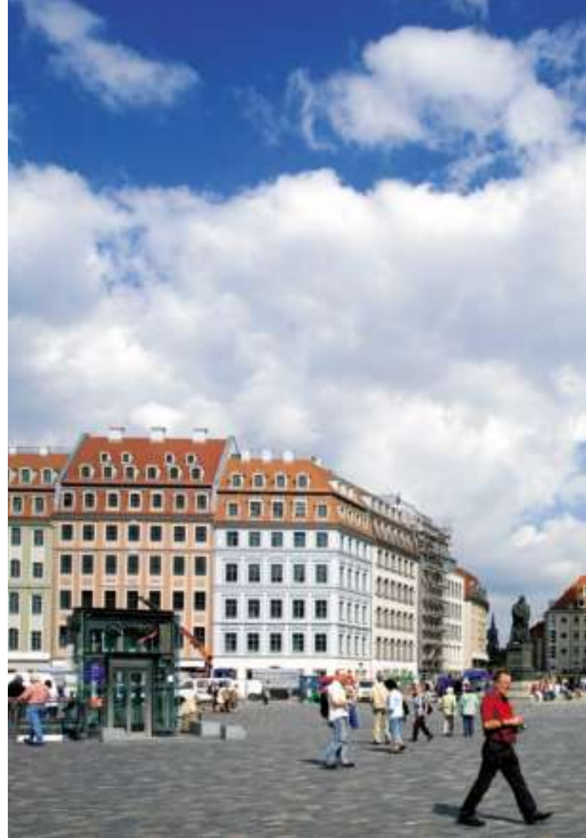
Einst die „gute Stube Dresdens“: das Neumarktviertel direkt an der Frauenkirche.
