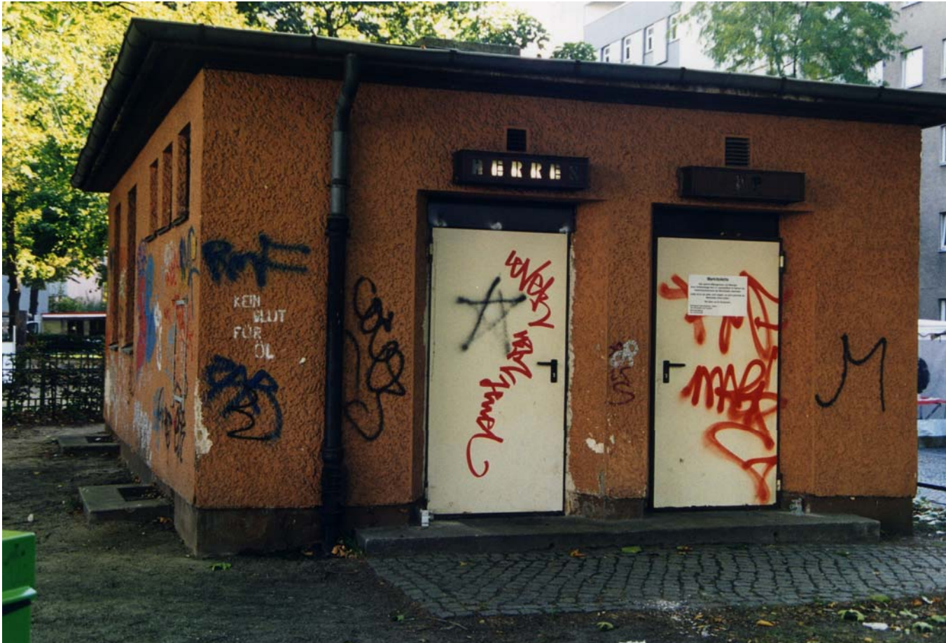
Eine der 285 öffentlichen Toiletten im Berliner Stadtgebiet steht am Karl-August-Platz
