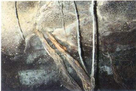
Wurzeleinwuchs im Deckenbereich sowie durch einmündende Rohrleitungen und Fugen im Natursteinmauerwerk
