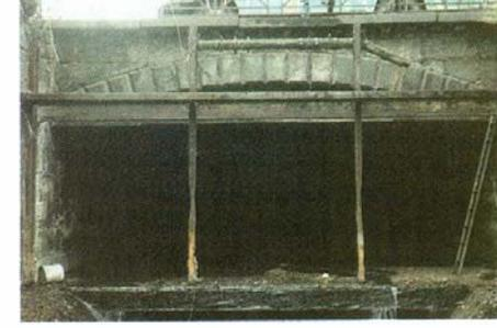
Auslaufbauwerk Rosentalbrücke, Fugenkorrosion im Natursteinmauerwerk
