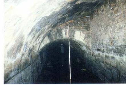
Ehemalige Brücke Friedrich-Ludwig-Jahn-Allee, korrodiertes Ziegelmauerwerk, Fugenkorrosion im Natursteinmauerwerk
