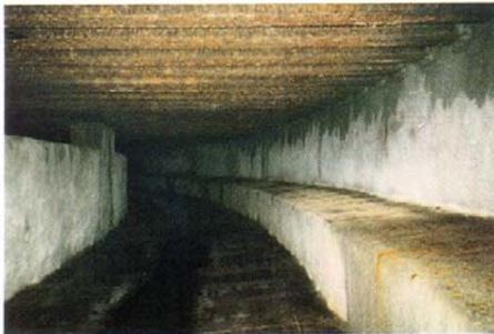
Regenrückhaltebecken Georgi-Dimitroff-Platz (Beginn), stark korrodierte Stahl - I - Träger mit Auflagerdurchfeuchtung
