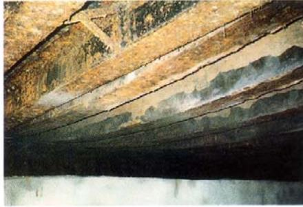
Regenrückhaltebecken Georgi-Dimitroff-Platz, Übergang Stahl - I - Träger – Fischbauchträger
