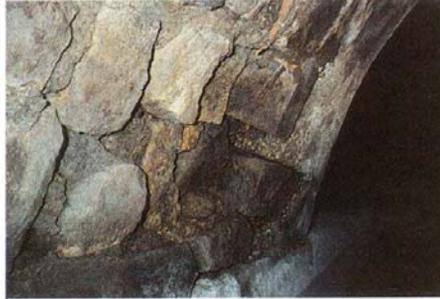
Natursteinmauerwerk (Bruchsteinmauerwerk) mit starker Fugenkorrosion bzw. fehlendem Fugenmaterial (Hohlfugen bis 10 cm Tiefe)
