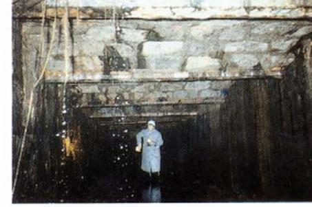
Starker Wassereinbruch, starke Träger- und Mauerwerkskorrosion im Bereich der Wände und der Kappendecke, Wurzeleinwuchs
