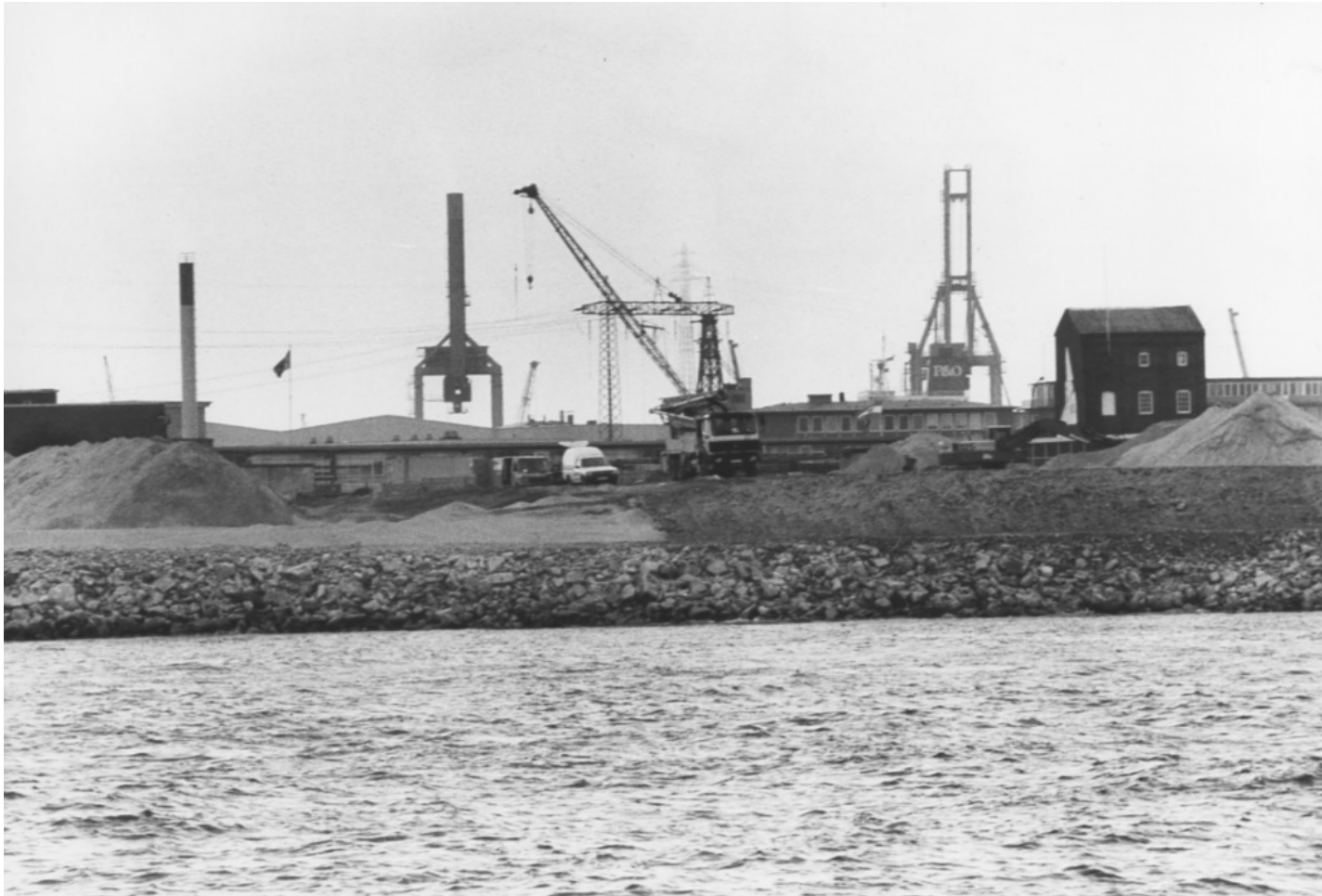
Hafen Hamburg – Areal nach Abriss der ehemaligen Stülcken - Werft
