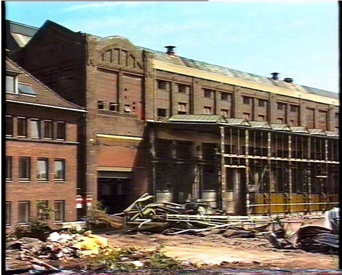
Halle vor Umbau
