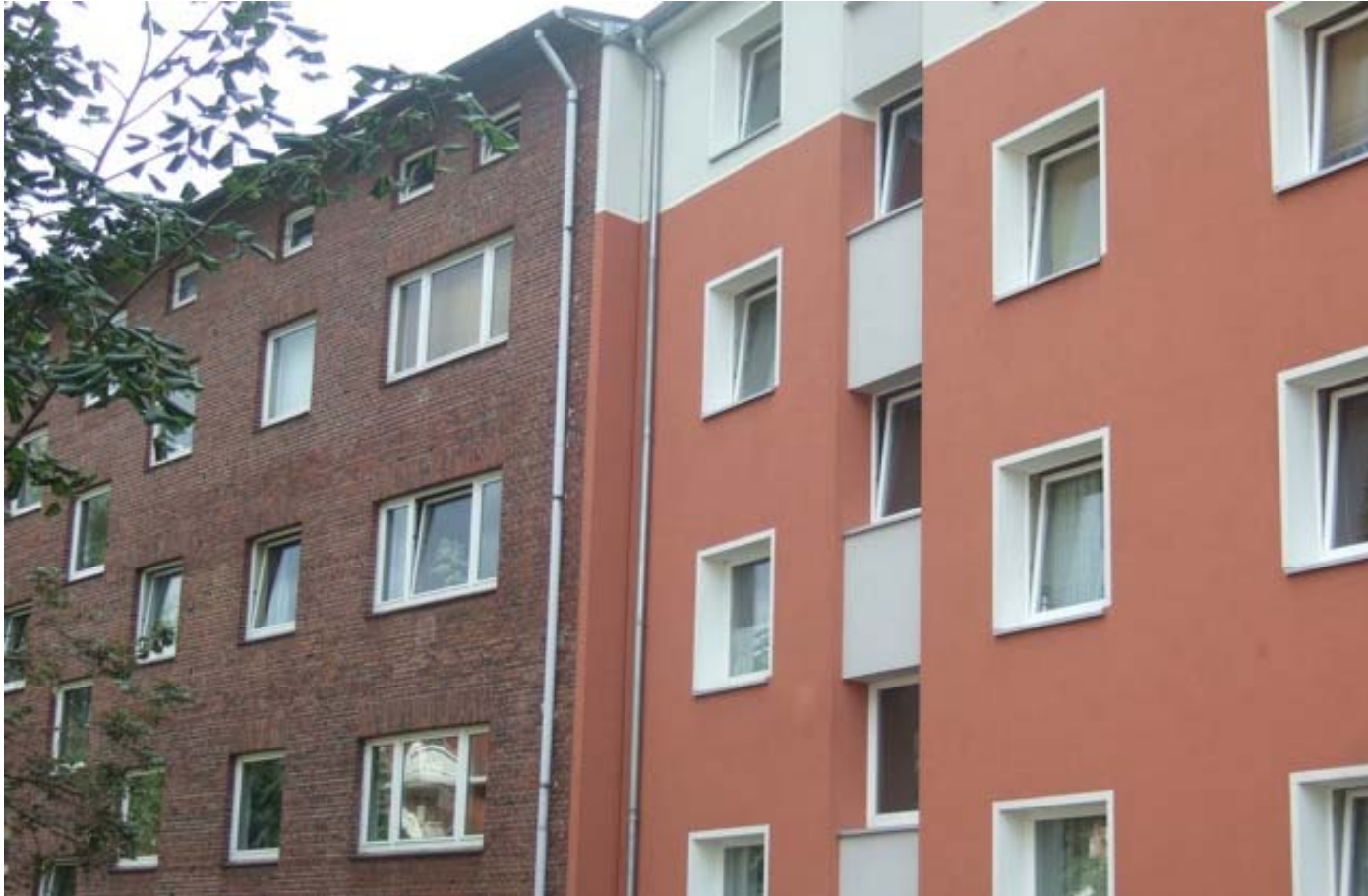
Alte Backsteinfassade neben wärmesaniierter Backsteinfassade in Hamburg
