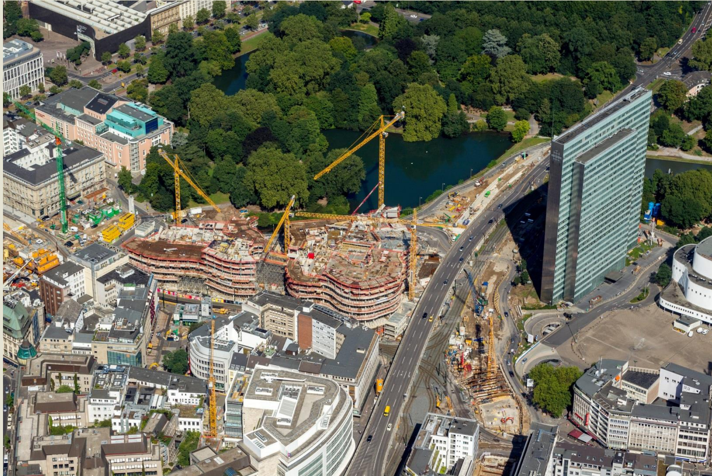
Bau des Kö-Bogens
