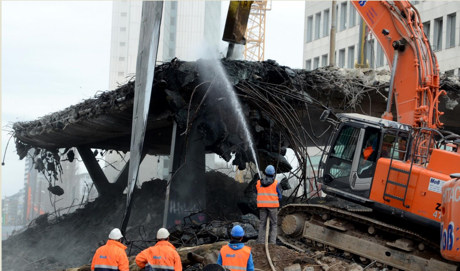
Abriss des „Tausendfüßlers“
