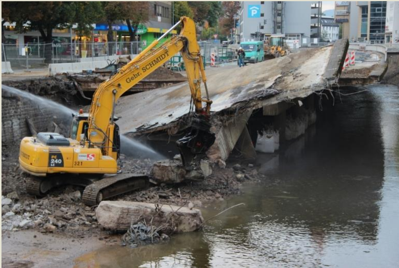
Das Ende eines Betondeckels Quelle: Universitätsstadt Siegen
