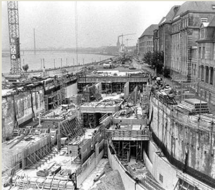
Bau des Rheinfertunnels
