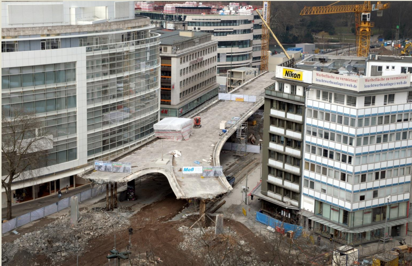
Abriss des „Tausendfüßlers“
