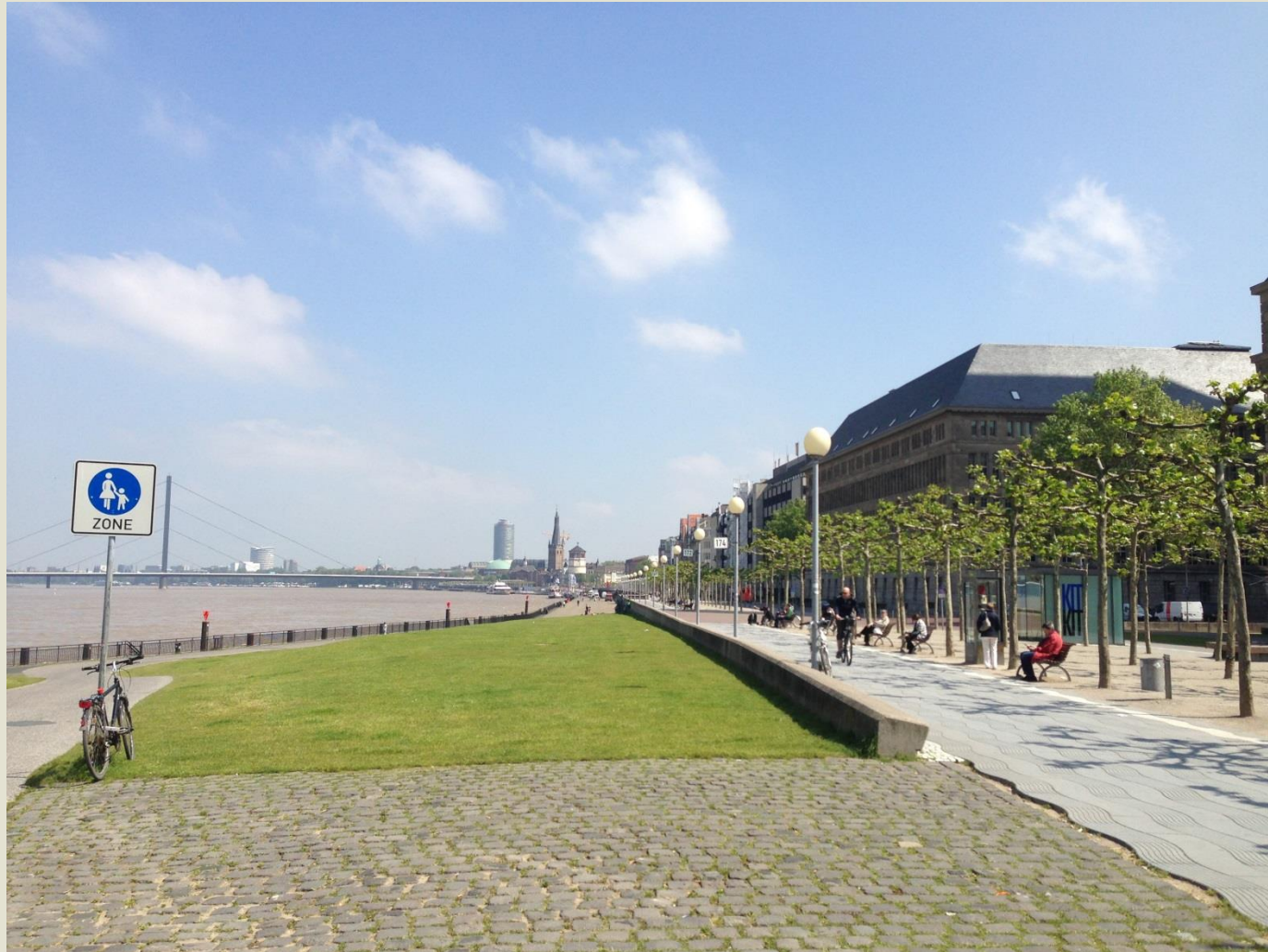
Neues Rheinufer, B1 verläuft im Tunnel
